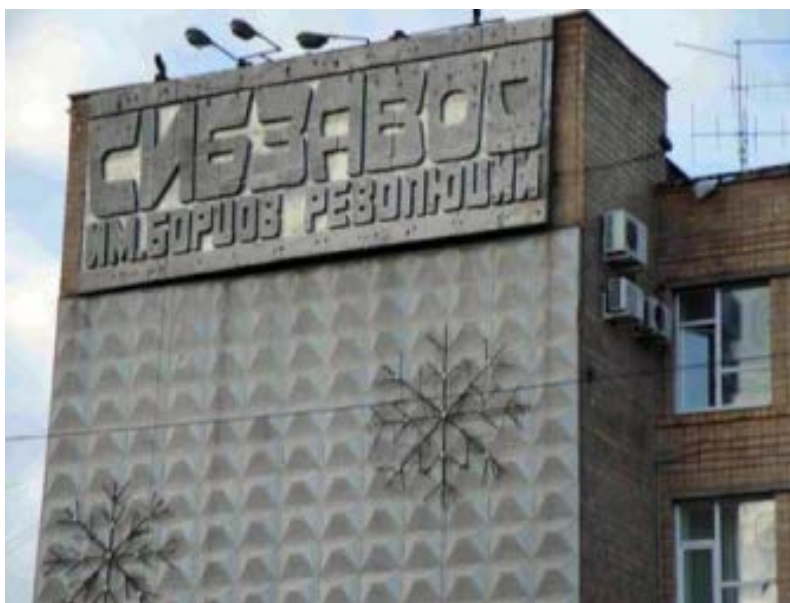
Рис. 3. Вывеска Сибзавода им. борцов революции
