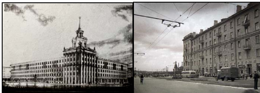
Рис. 3. От проекта до реализации. Жилой дом Омского шинного завода. 1955. Арх. А. И. Юмакаев
